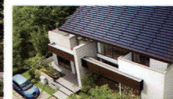
太陽光発電システム
