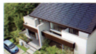
太陽光発電システム
