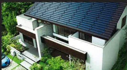
太陽光発電システム
